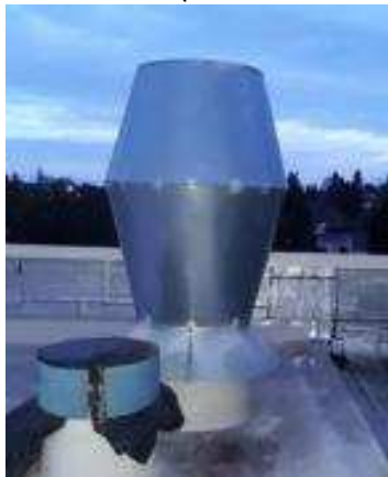
Avant Travaux (décembre 2017).
