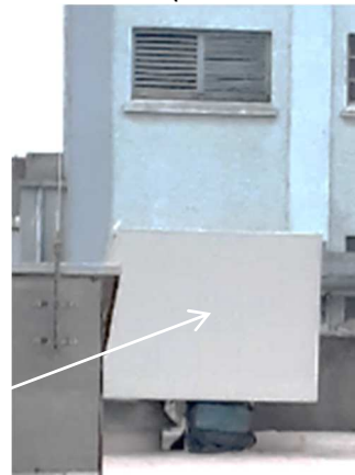
Après Travaux (décembre 2018).
