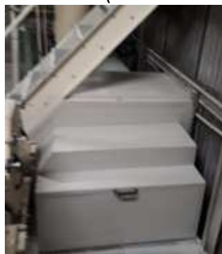
Après Travaux (décembre 2018).
