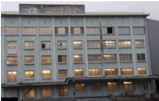
Avant Travaux (décembre 2017).
