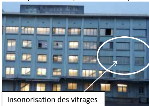
Après Travaux (décembre 2018).
